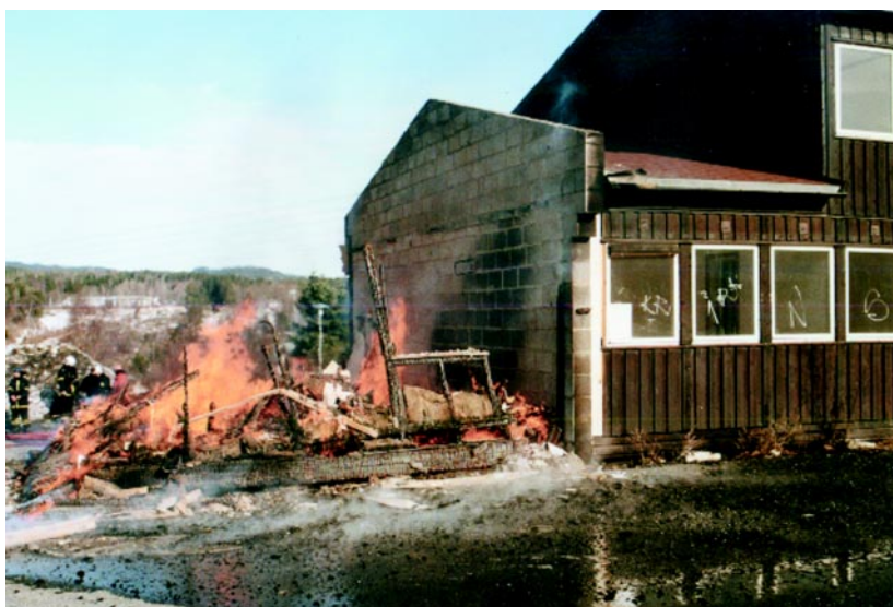
Fra brannførsøk på rekkehus i Bærum 1999. Seksjoneringsvegg av Leca hindret brannspredning til naboelligheten uten innsats fra brannvesenet, som imidlertid var tilstede og kontrollerte forsøket.
